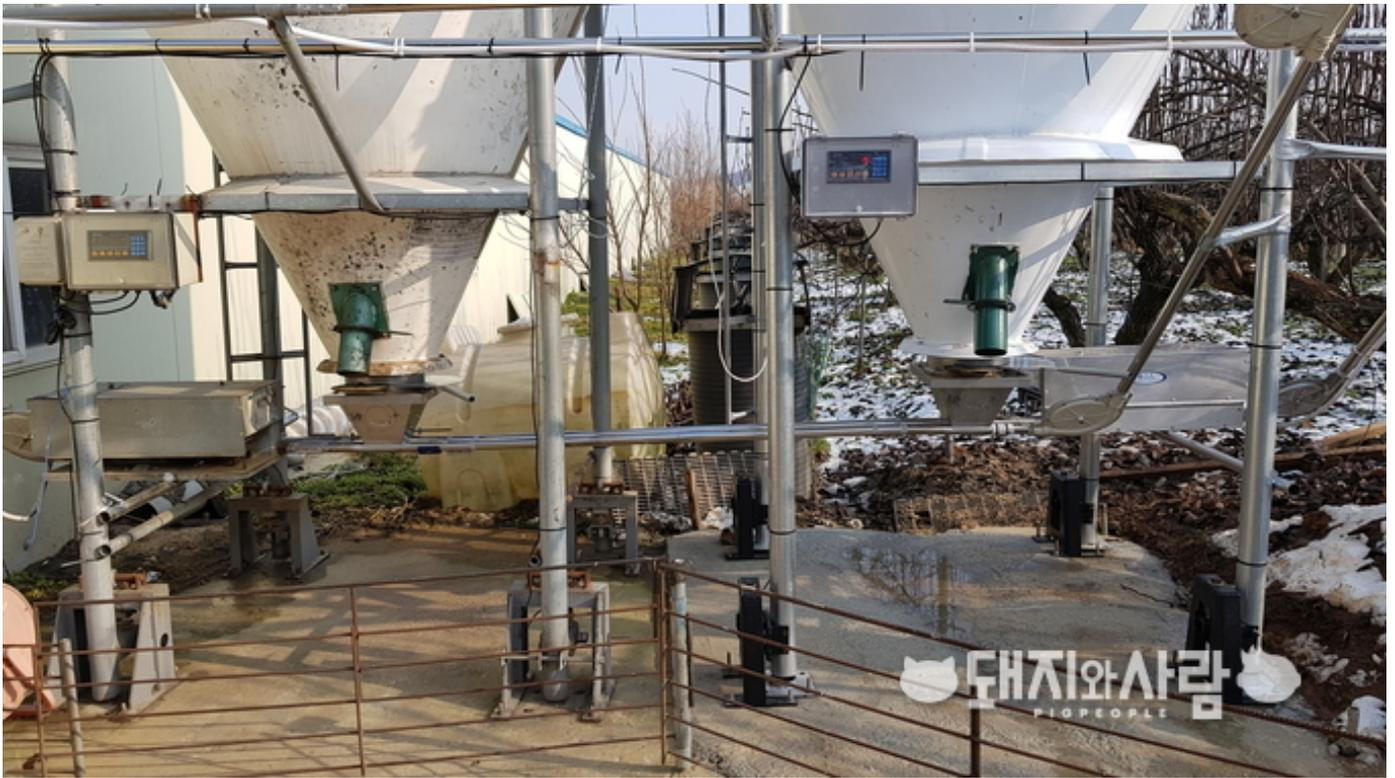
▲ 로드셀을 이용한 사료빈 재고 모니터링 시스템
