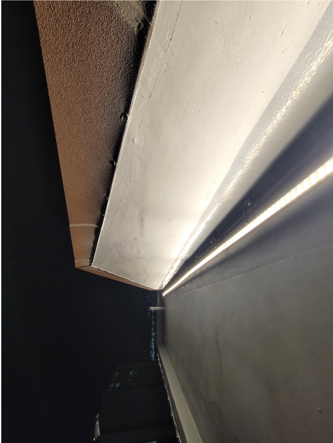
<옥탁 옥상에 고급 월워셔 라인투광기인 이지엠테크 라이트 샤워를 설치>
