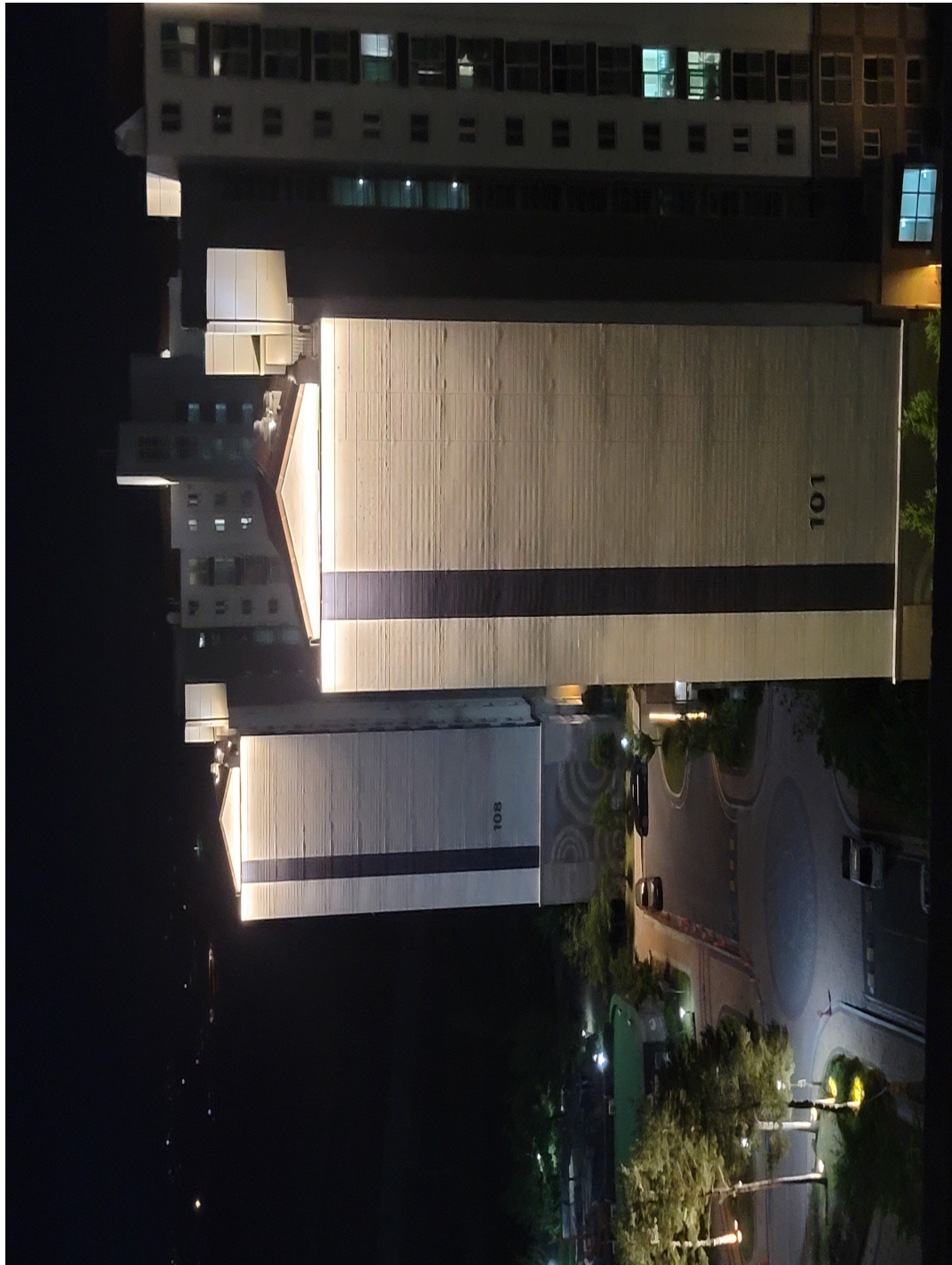
<외벽 상단에 설치한 빛이 1층까지 은은하게 전달되는 모습(월워셔 라인투광기 특징)>
