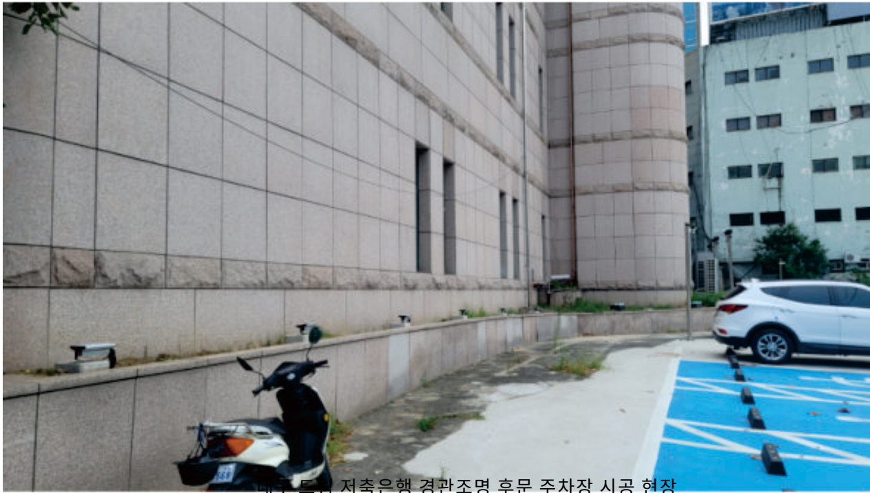
대구 드림 저축은행 경관조명 후문 주차장 시공 현장
