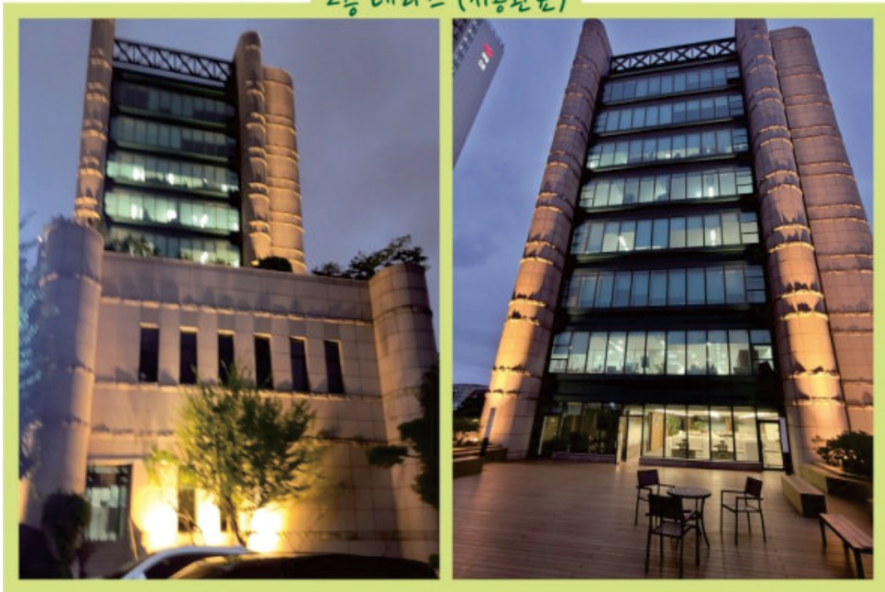
2층 테라스 (시공완료)
