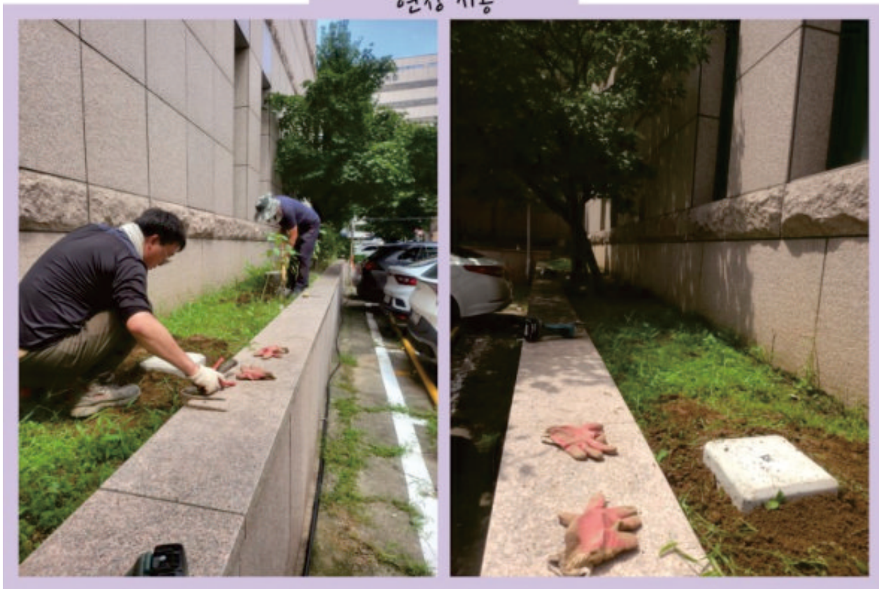
경관조명 설치를 위한 기초 콘크리트 매설 작업중1
