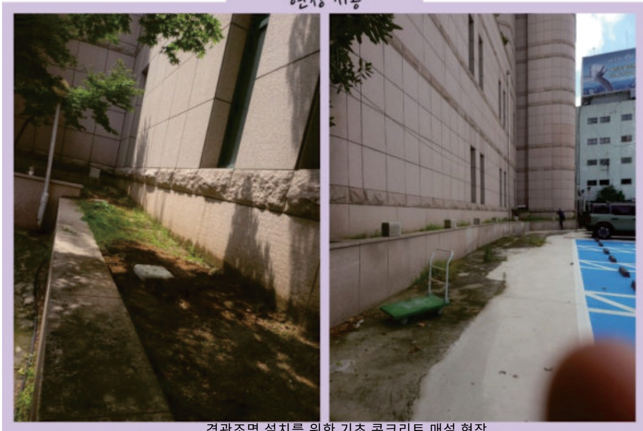
경관조명 설치를 위한 기초 콘크리트 매설 현장
