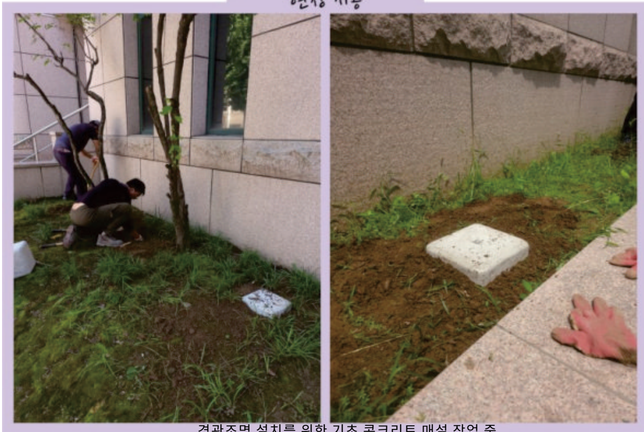
경관조명 설치를 위한 기초 콘크리트 매설 작업 중
