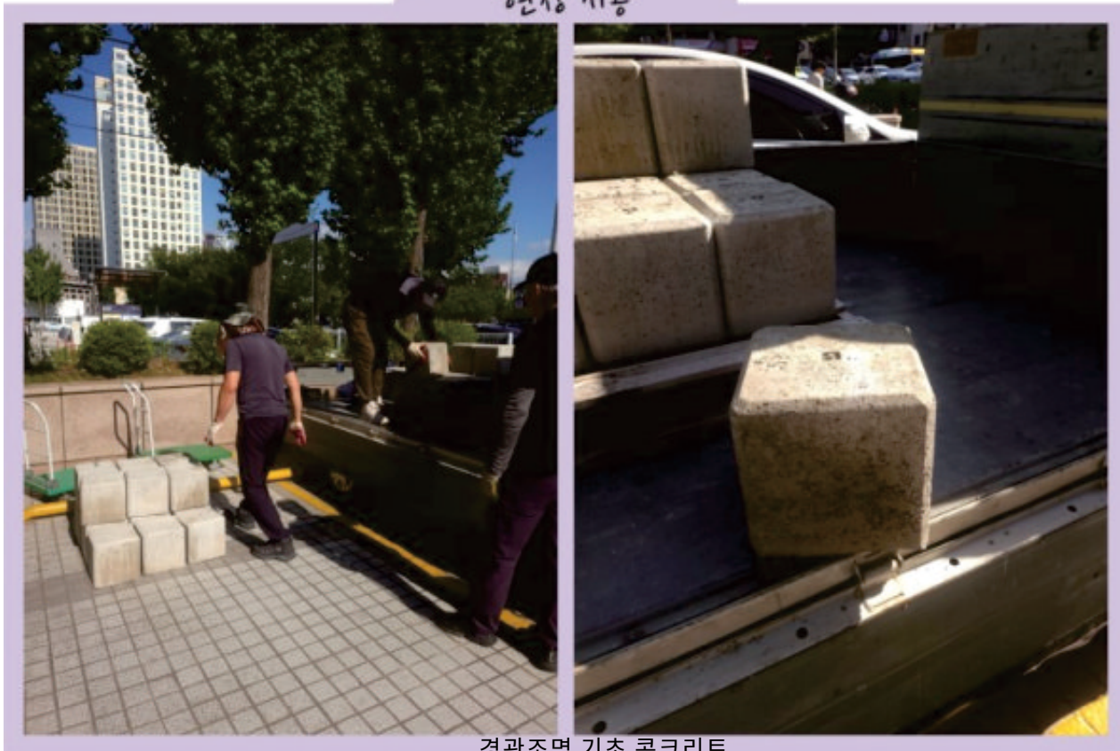
경관조명 기초 콘크리트
