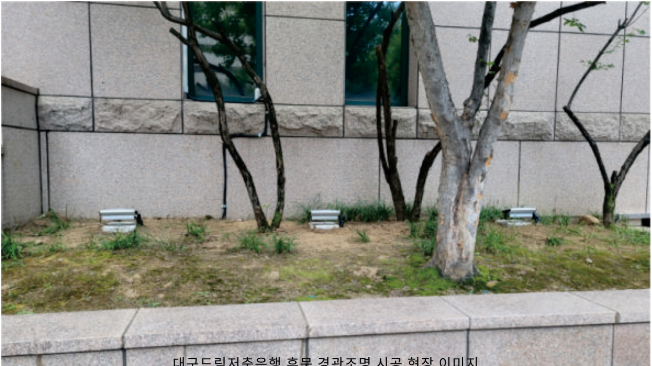
대구드림저축은행 후문 경관조명 시공 현장 이미지
